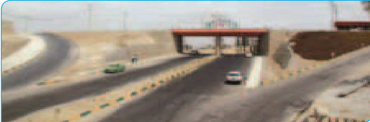
احداث پل شهید بهشتی
