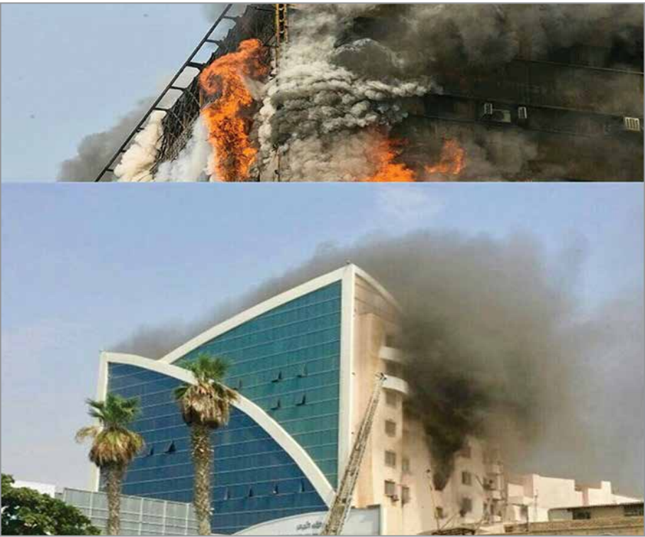
آتش سوزی در ساختمان پلاسکو در بندرعباس، ۱۳۹۵
