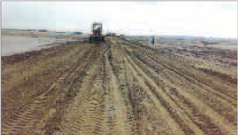
بعد از اجرای عملیات
